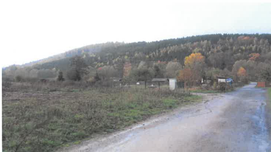
Blickrichtung Süd mit MI – 2 Flächenanspruch durch Versorgungsanlage Trinkwasser
