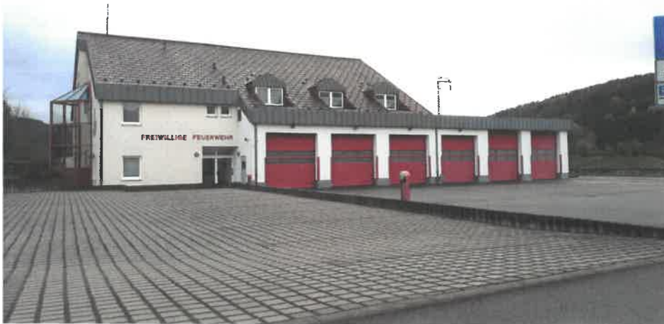
Feuerwehrhaus der Stadt Wasungen
